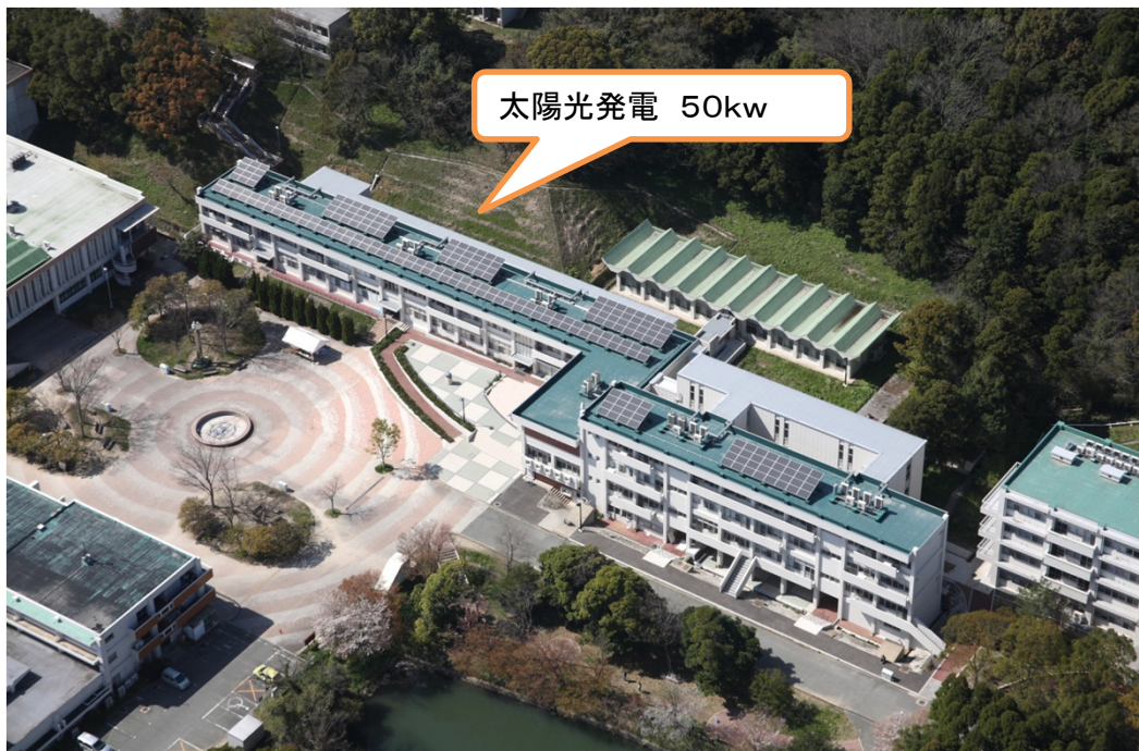
太陽光発電設備 50kw (平成22年2月竣工:赤間キャンパス共通講義棟)
